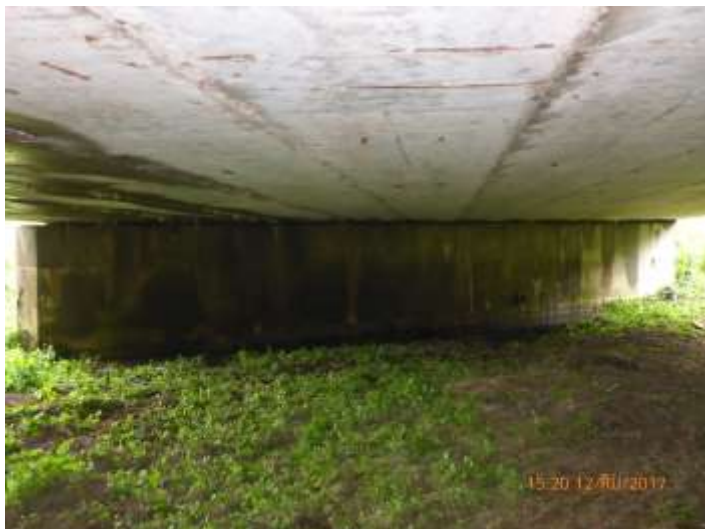
Pohled na opěru 3 po směru staničení. Silné potékání opěry v celé ploše.
