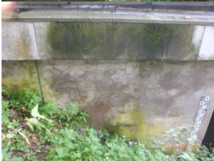
Křídlo opěry 1 vpravo + bok opěry Všesměrné trhliny v omítce boku opěry a křídla
