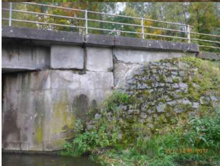
Křídlo opěry 1 vlevo + bok opěry Odpadlá krycí vrstva a povrchová degradace betonu křídla.
