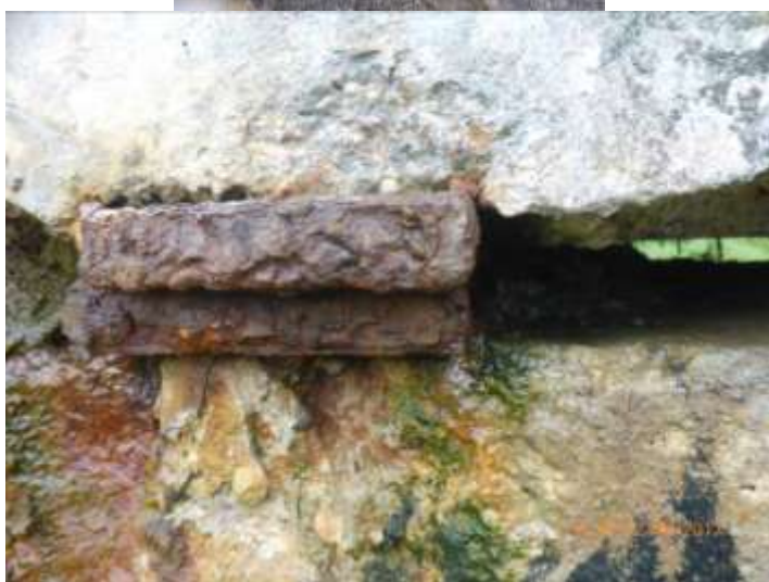
detailní pohled na ocelolitinové desky ložisek z boku. Opěra 3 vlevo.
